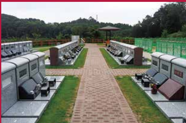
川崎市立早野聖地公園／壁面墓地施設整備工事
