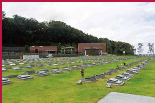
公営 稲城・府中メモリアルパーク／施設整備工事
